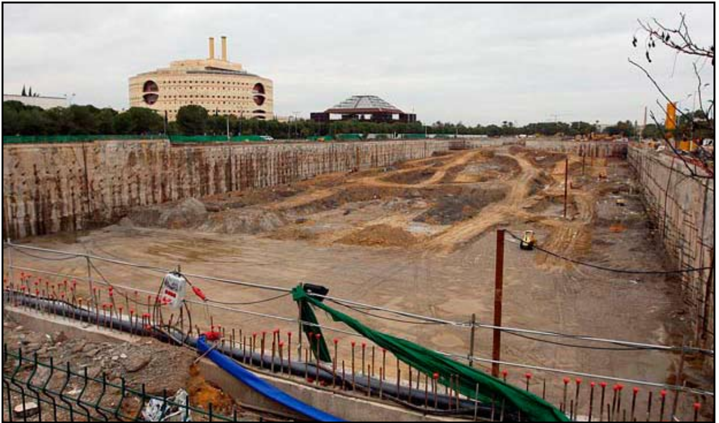
Aspecto de las obras de cimentación para la Torre Pelli, el 07-01-2010 en la isla de La Cartuja (Sevilla). / PÉREZ CABO
